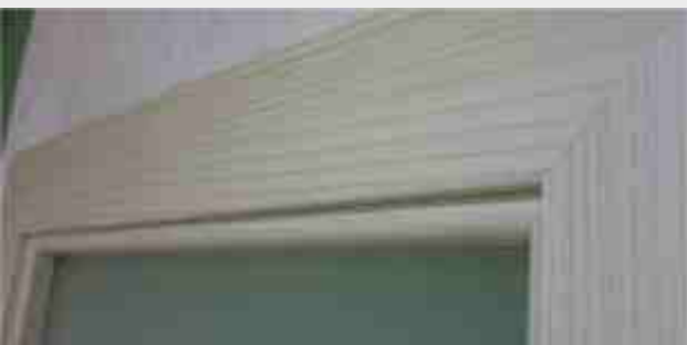
Фрамуга Verto-FIT с матовым стеклом и установленным штапиком
