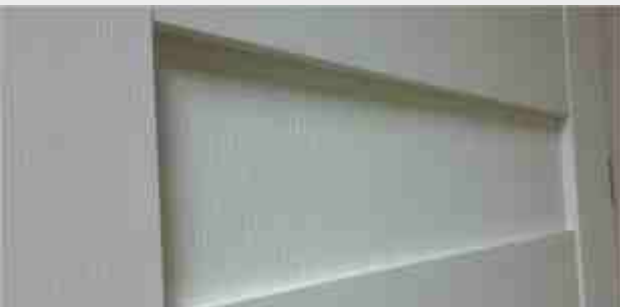
Филенка ХДФ, окутанная в цвет полотна, установленная без обклада
