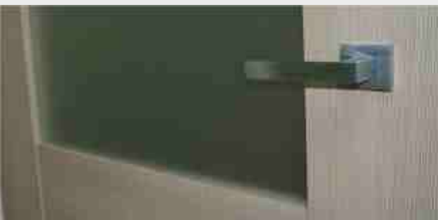
Стекло матовое, установленное без обклада (в паз деталей полотна)
