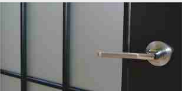
Стекло сатин установленное с обкладом Г17 (овальный)
